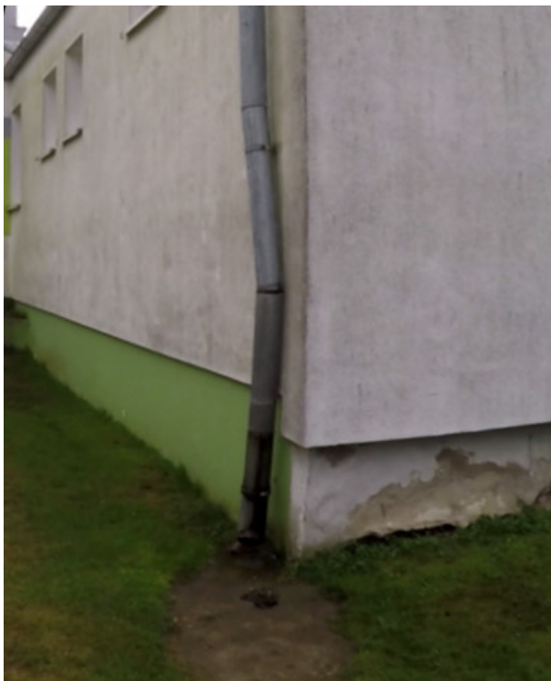
Zdjęcie 1 Rura spustowa – północny narożnik sali gimnastycznej. Woda odprowadzona na teren.
