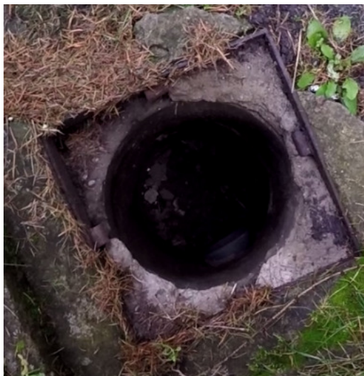
Zdjęcie 5 Zbliżenie na studzienkę ze zdjęcia powyżej - widoczne odprowadzenie do studni drenażowej
